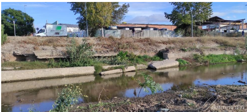
Figura 38. Detall de la zona de l'endegament que s'ha fet mal bé.
