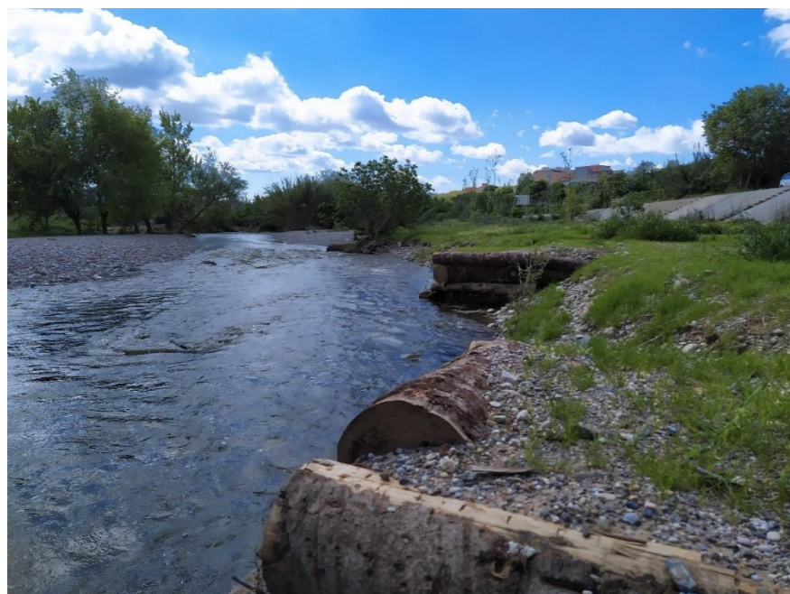
Figura 13. Detall dels deflectors vius estructurats amb krainer. Projecte de recuperació mediambiental de la llera del Ripoll a Ripollet. Fase 1. Finalitzat en data 13 de març de 2020.
