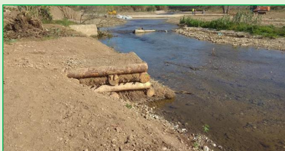
Figura 2. Deflectors vius estructurats amb Krainer acabats de construir a la zona de Molí d'en Xec.
