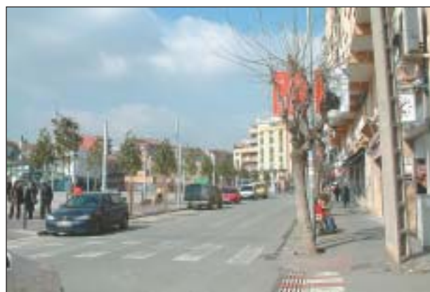
VISTES ACTUALS DELS CARRERS A L'INICI DE LES OBRES.
