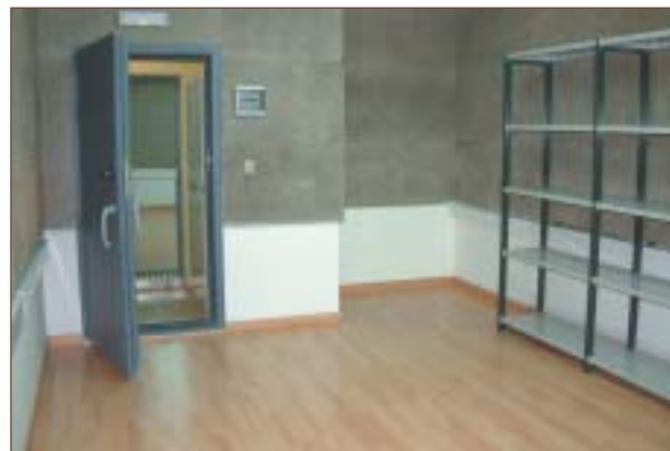
ARXIU: UN DELS LOCALS D'ASSAIG, ACABAT DE REFORMAR AL 2007
