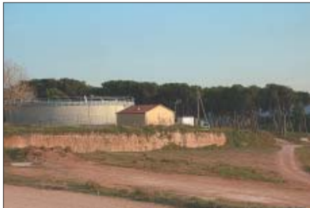
L'ANTIC DIPÒSIT TÉ 2.400 METRES CÚBICS
