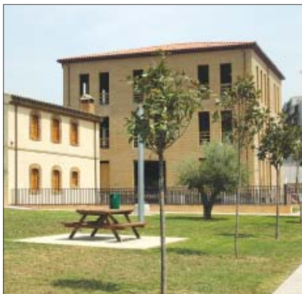
EL PMO S'HA ENCARREGAT, A TRAVÉS DE DIVERSES ESCOLES TALLER, DE LA RESTAURACIÓ DEL L'ANTIC MOLÍ D'EN RATA I DE LA CONSTRUCCIÓ DEL CIP.
