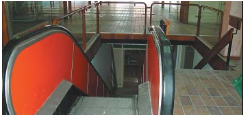
EL CONSISTORI APORTARÀ 24.000 EUROS PER A LA REMODELACIÓ DE LES ESCALES DE LES GALERIES. (FOTO: eBR)
