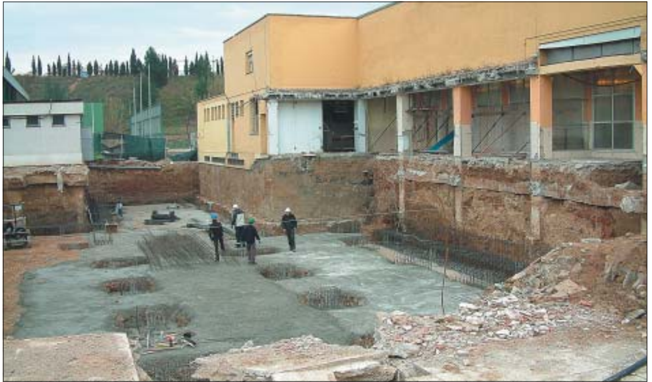
ELS OPERARIS TREBALLANT EN EL FORJAT DEL VAS DE LA PISCINA. (FOTO: EBR)
