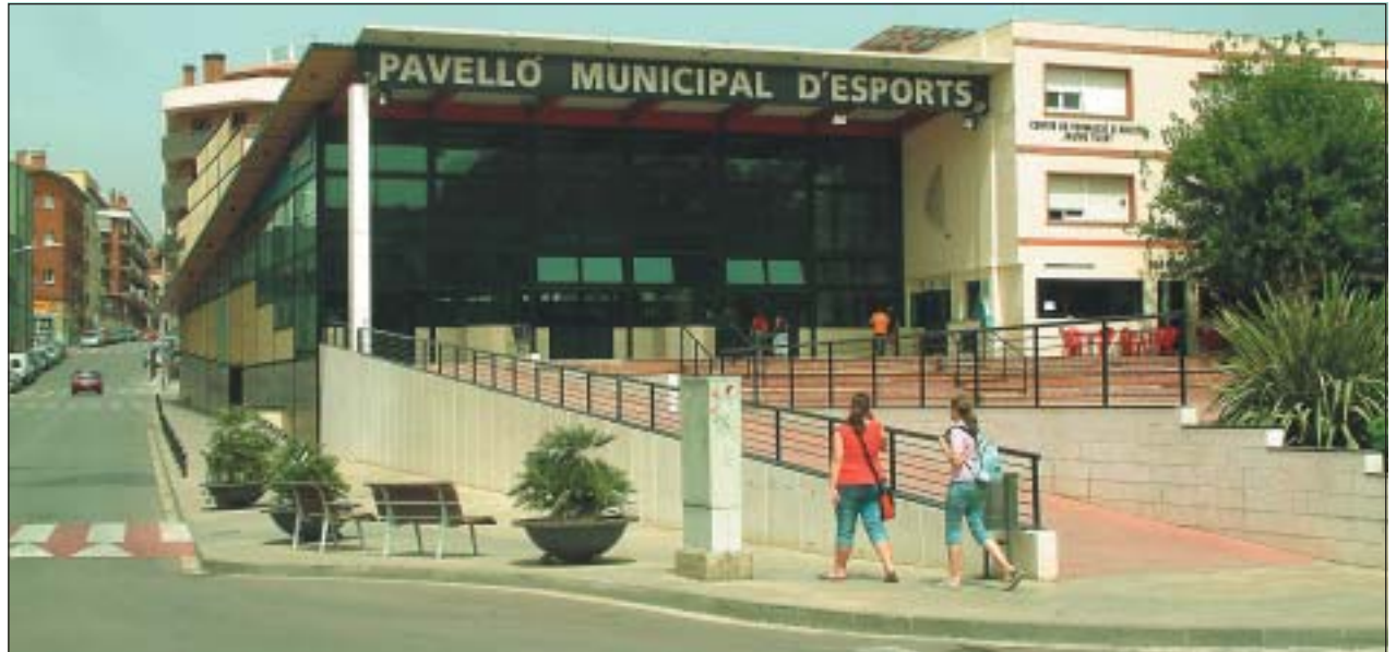
VISTA GENERAL DEL PAVELLÓ MUNICIPAL D'ESPORTS DE RIPOLLET. (FOTO: EBR)
