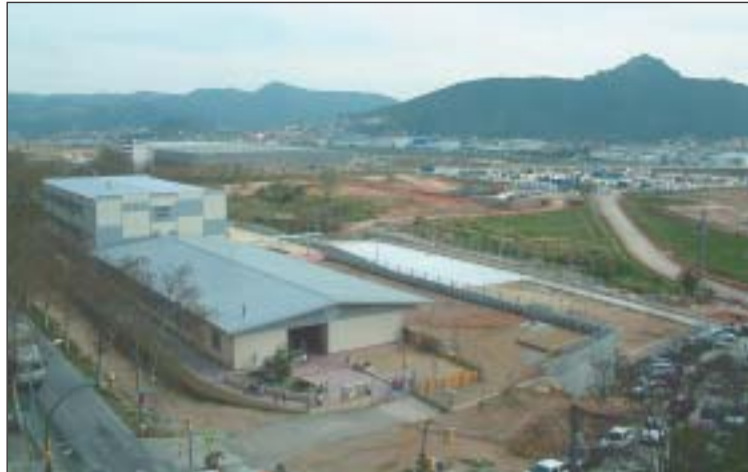
Ja han començat els moviments de terres al voltant de l'escola El Martinet
