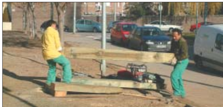
Operaris substituïnt travesses tractades amb creosota per altres ecològiques, al parc Gaudí
