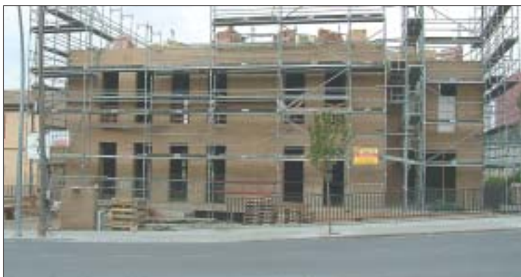
Continuen els treballs de construcció de l'edifici annex del Molí d'en Rata a càrrec del PMO
