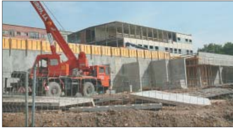
Continuen els treballs de la segona fase del CEIP El Martinet
