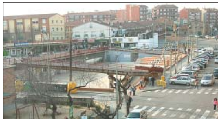
Vista de la plaça de Pere Quart, abans d'enderrocar la passarel·la
