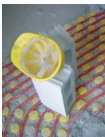
Sota el parquet, calefacció radiant de serpentins d'aigua calenta, escalfada per plaques solars
