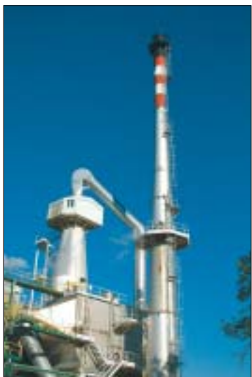
Incineradora de Montcada
