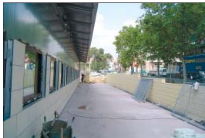
Vista de les obres del parvulari de l'escola Teresa Vila i Arrufat
