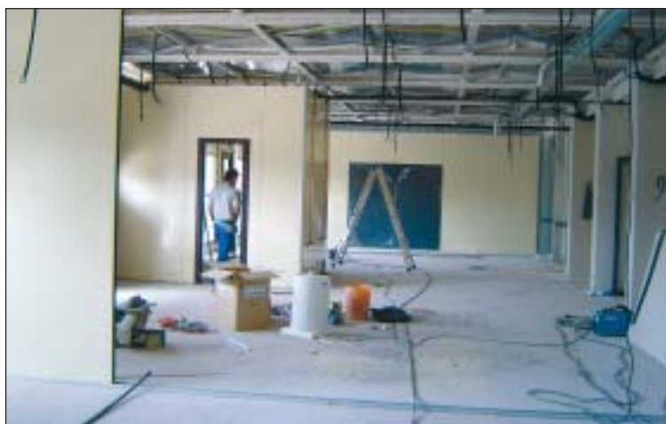
Les obres del nou col·legi de Can Mas, a mitjan juliol
