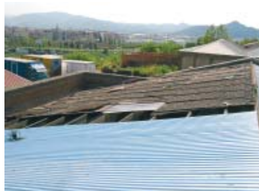
S'han substituït 225 m 2 d'uralita per xapa ondulada d'acer galvanitzat
