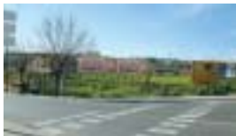
L'Escola Bressol es construirà a la cantonada dels carrers de Molió i en Rata i de Magallanes
