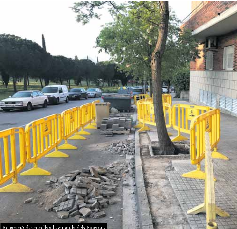
Reparació d'escocells a l'avinguda dels Pinetons
