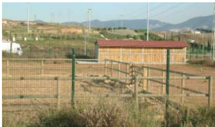
Les instal·lacions es troben al costat del viver municipal, a la carretera de Santiga
