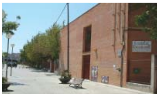
En el Escursell se renovará la canalización del alcantarillado
