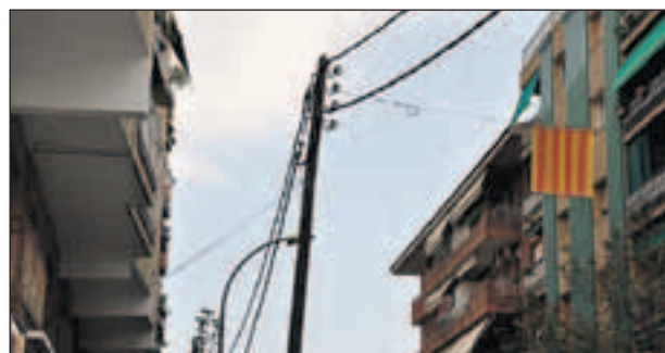
ES SOTERRARÀ EL CABLEJAT ELÈCTRIC
