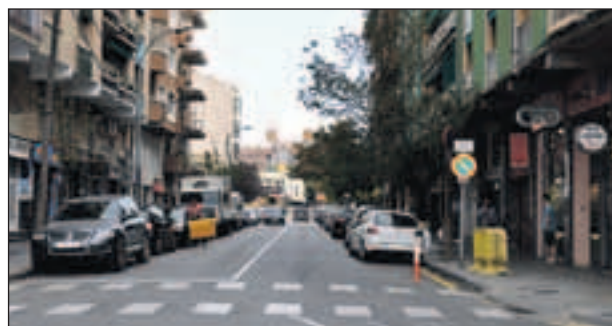
VISTA GENERAL DEL TRAM QUE ES REMODELARÀ
