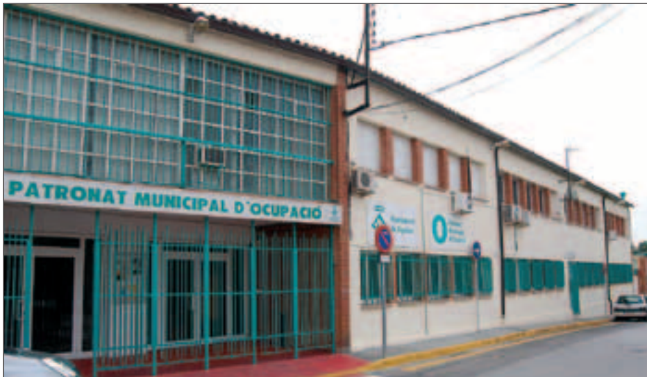
INSTAL·LACIONS DEL PMO, AL CARRER DE SANT SEBASTIÀ 26
