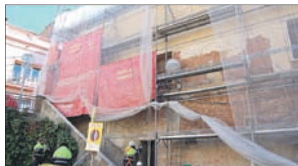
REHABILITACIÓ DE L'EDIFICI DE SERVEIS SOCIALS
