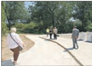
LA SUBDELEGADA DEL GOVERN, ACOMPANYADA PER MEMBRES DEL CONSISTORI, VISITA LES OBRES DEL CARRIL BICI A RIPOLLET
