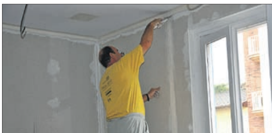
CONSTRUCCIÓ DE LA NOVA REDACCIÓ MULTIMÈDIA DEL PATRONAT DE COMUNICACIÓ
