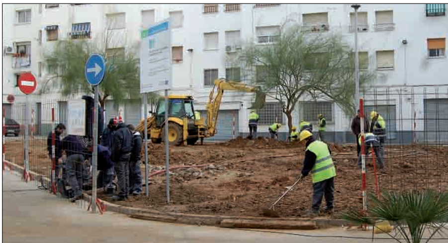
DURANTE LAS OBRAS DE MEJORA
