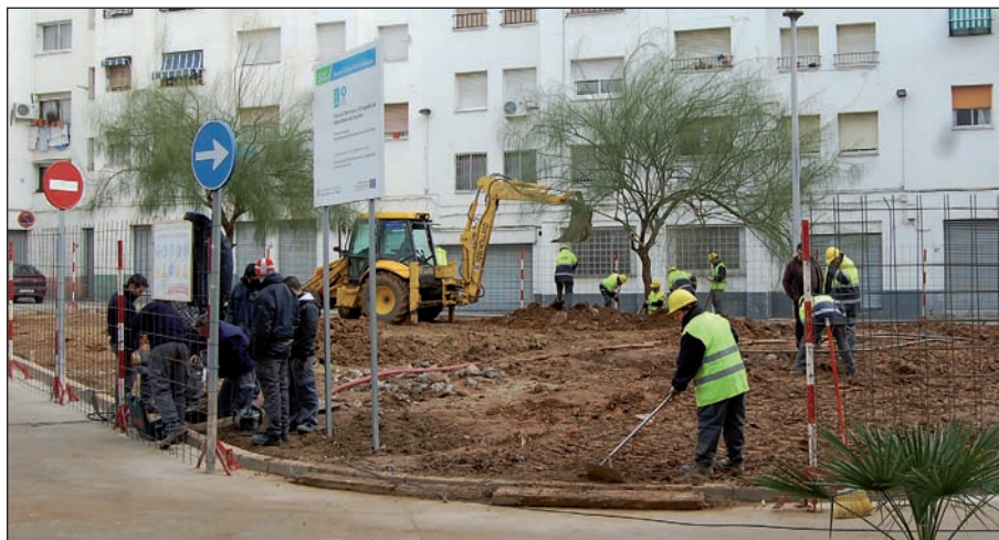
DURANT LES OBRES DE MILLORA
