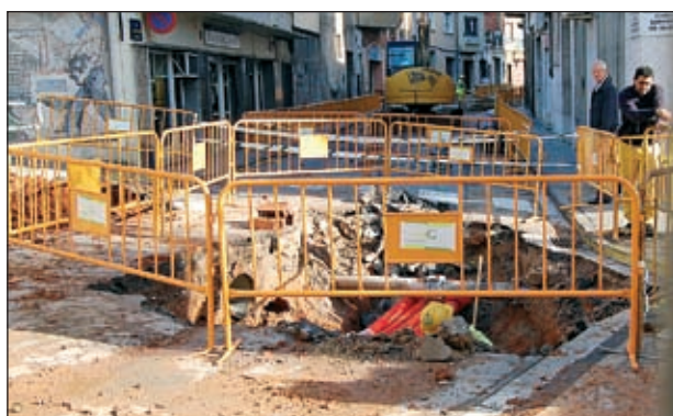
CANVI DEL CLAVEGUERAM A LA CRUÏLLA DE PADRÓ AMB CALVARI
