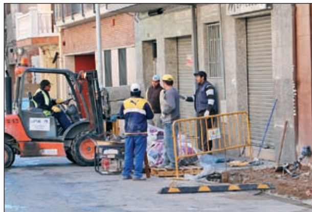
DURANT ELS TREBALLS DE MILLORA AL CARRER DE CALVARI
