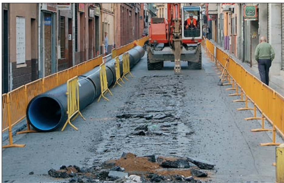
PRIMER DIA DE LES OBRES DEL CARRER DE PADRÓ, CANTONADA RAMBLA DE SANT JORDI
