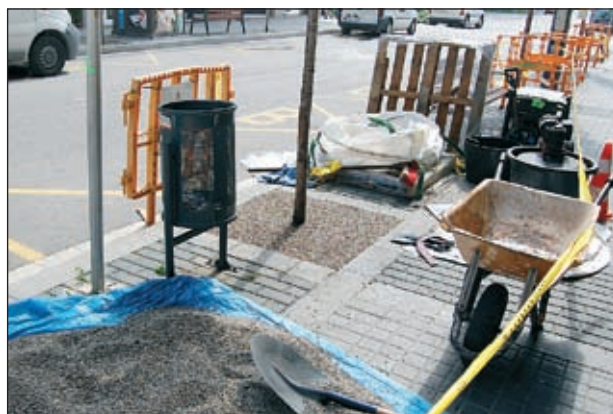
INICI DELS TREBALLS A LA RAMBLA DE SANT JORDI
