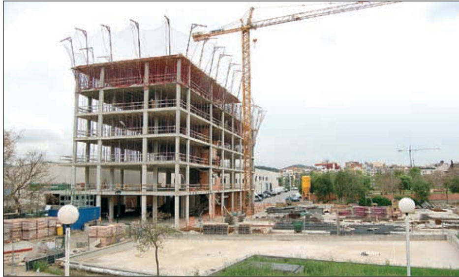
L'EMPRESA AUBAREL OBTINDRÀ FINANÇAMENT HIPOTECANT LA CONCESSIÓ DE L'APARCAMENT DEL RIU
