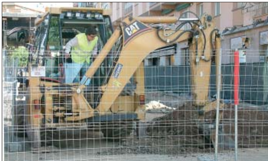
LES OBRES VAN COMENÇAR EL PASSAT MES DE MAIG I VAN ACABAR A L'ESTIU
