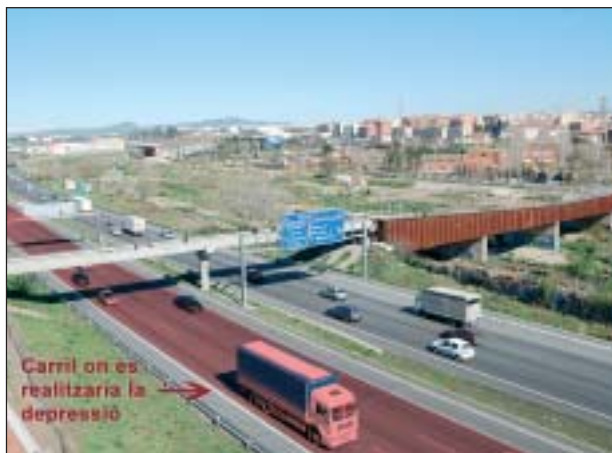
LA DEPRESSIÓ AFECTARIA LA CALÇADA DRETA EN DIRECCIÓ BARCELONA, LA MÉS PROPERA ALS HABITATGES
