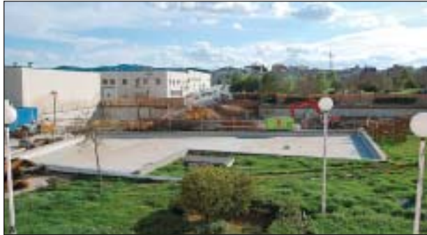
L'APARCAMENT AL PRINCIPI DE L'OBRA
