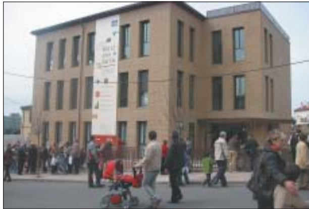
EL CIP HA ESTAT CONSTRUÏT PEL PATRONAT OCUPACIÓ
